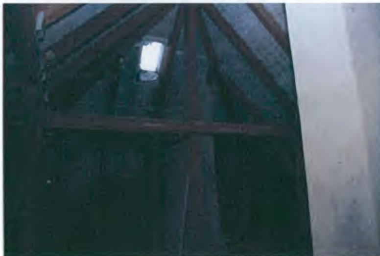
Fot. Nr. 5.5 Płatwiowo-kleszczowa więźba dachowa nad bryłą główną budynku
