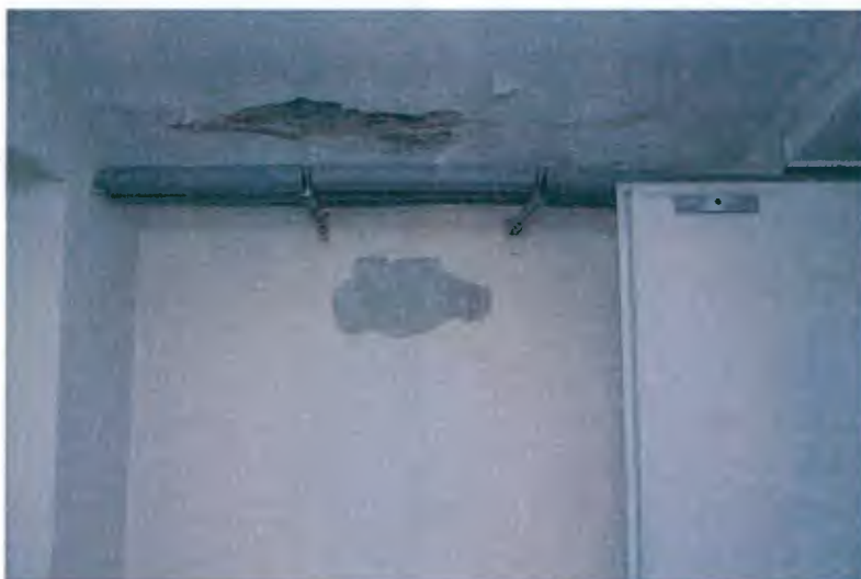
Fot. Nr. 6.9 Zawilgocenie stropu oraz ścian pod głównym wejściem do budynku
