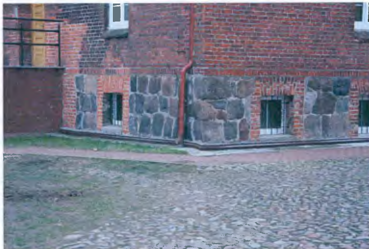
Fot. Nr. 5.1 Zewnętrzne ściany fundamentowe z ociosanych głazów kamiennych
