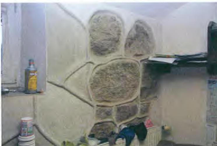
Fot. Nr. 5.2 Wewnętrzne ściany fundamentowe z ociosanych głazów kamiennych
