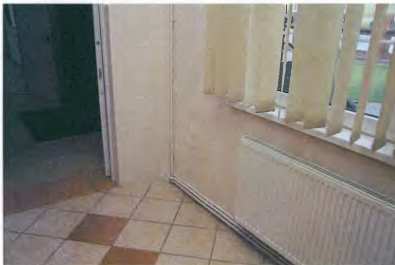
Fot. Nr. 6.3a Zawilgocone zewnętrzne ściany parteru
