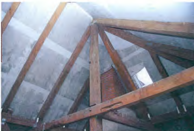
Fot. Nr. 6.10 Widoczne powierzchniowe ubytki w drewnianych elementach konstrukcyjnych dachu
