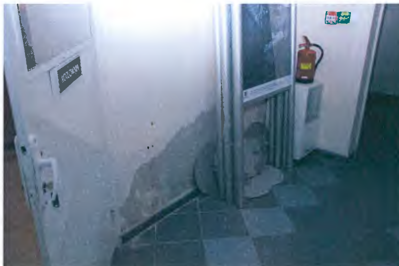
Fot. Nr. 6.2 Odpadający tynk ze ścian piwnicy na skutek zawilgocenia
