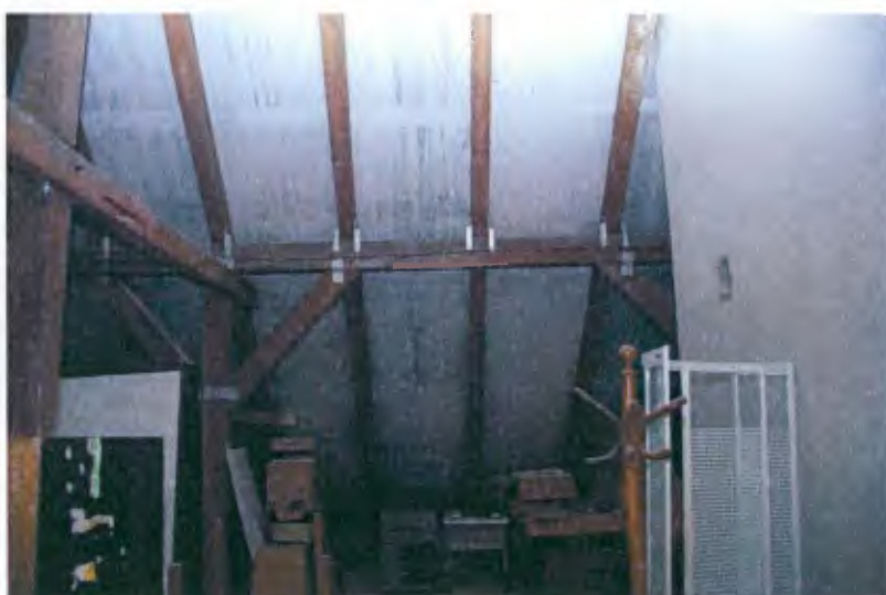
Fot. Nr. 6.11 Liczne pęknięcia podłużne elementów konstrukcyjnych dachu
