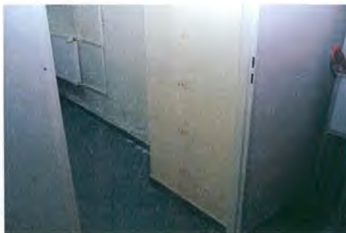
Fot. Nr. 6.1 łuszczący się tynk zawilgoconych ścianach fundamentowych
