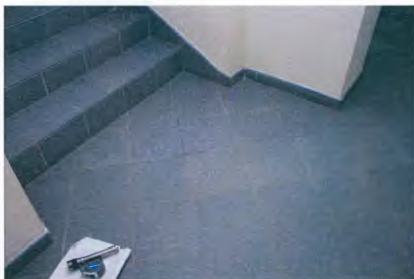
Fot. Nr. 6.13 Obluzowane płytki gresowe w miejscu zejścia do piwnicy
