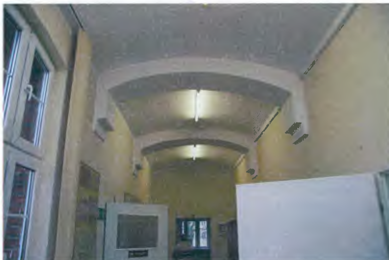
Fot. Nr. 5.4 Sklepienia traktów korytarzowych z cegły pełnej
