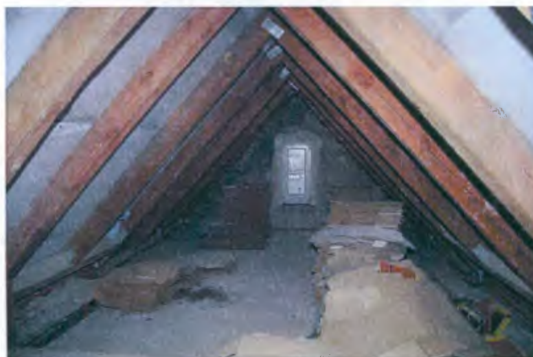
Fot. Nr. 5.6 Krokwiowa więźba dachowa nad skrzydłami budynku
