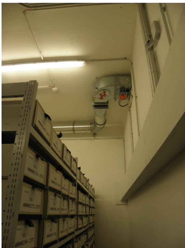
Przewody wentylacyjne odbierające powietrze z magazynu umieszczone po drugiej stronie pomieszczenia pod sufitem
