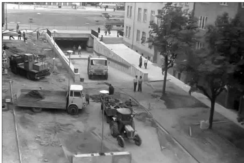
Budowa przejścia podziemnego przy ul Świerczewskiego (dziś Dworcowa), 1975 r. Fot. domena publiczna
