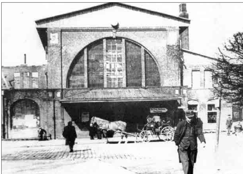
Częściowo odbudowany dworzec kolejowy, 1949 r. Fot. Mieczysław Matijas
