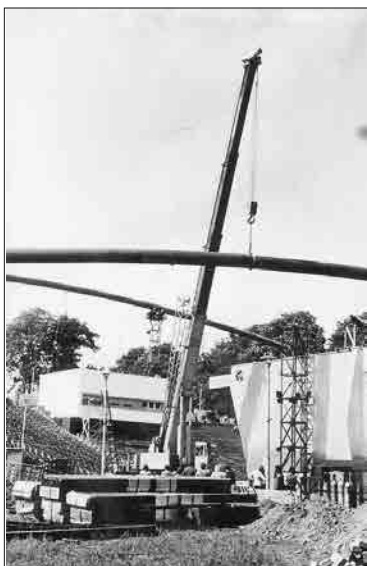
Budowa dachu amfiteatru, 1975 r.
