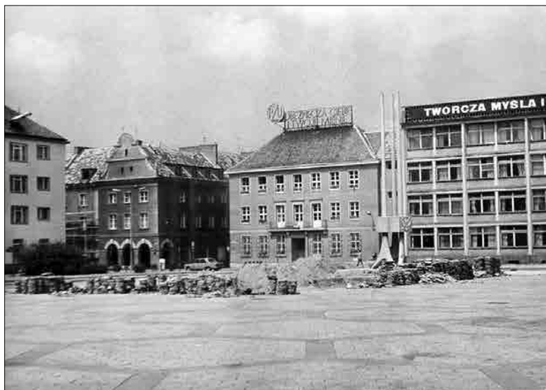
Budowa fontanny na rynku, 1975 rok. Fot. Jerzy Danielak
