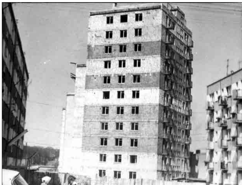
Budowa pierwszych koszalińskich wieżowców przy ul. Powstańców Wlkp. 1966 r. Fot. ze zbiorów Roberta Kasprowiaka
